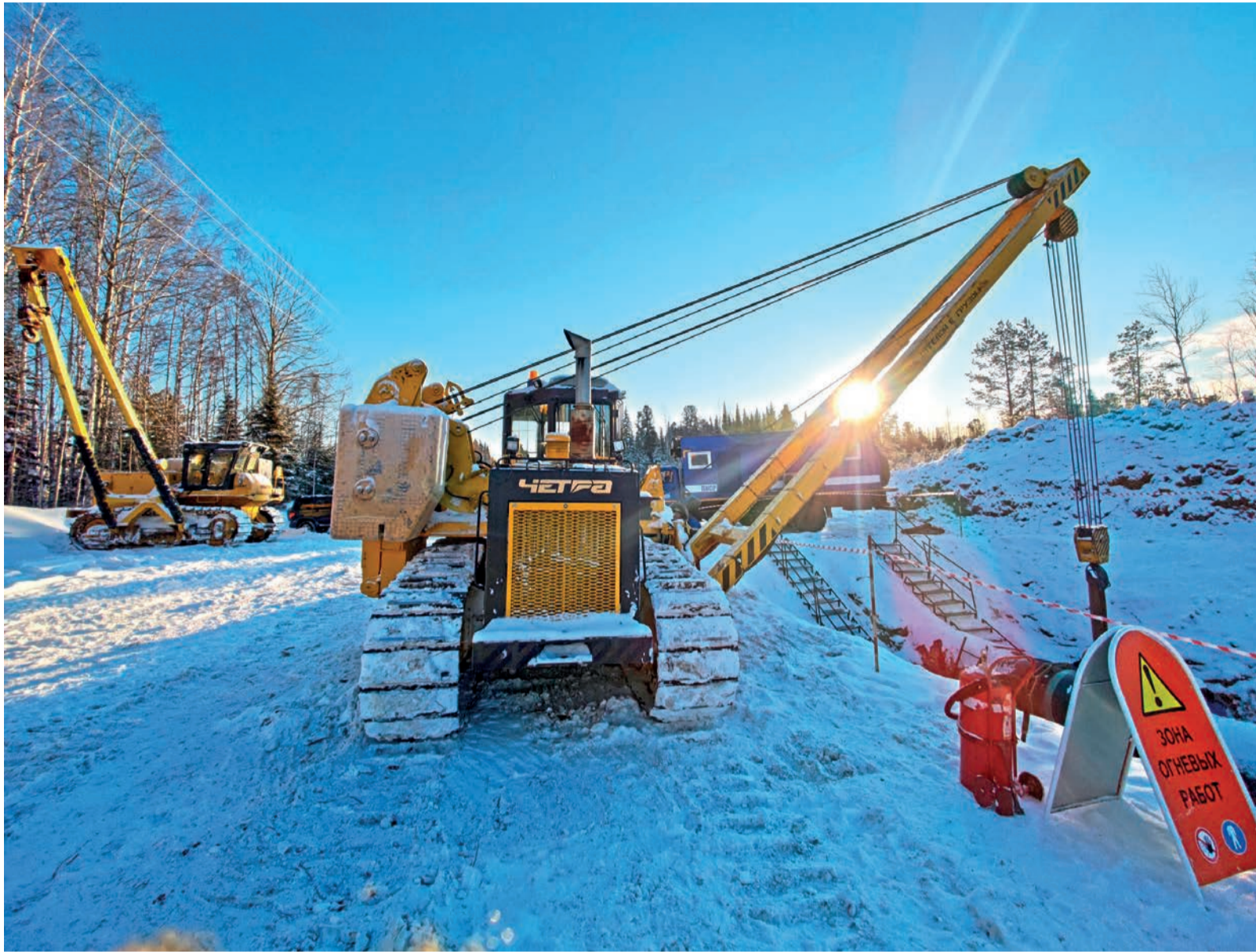
Ремонтные работы на магистральном газопроводе Нижневартровский ГПЗ – Парабель – Кузбасс. Подробнее – стр. 3
