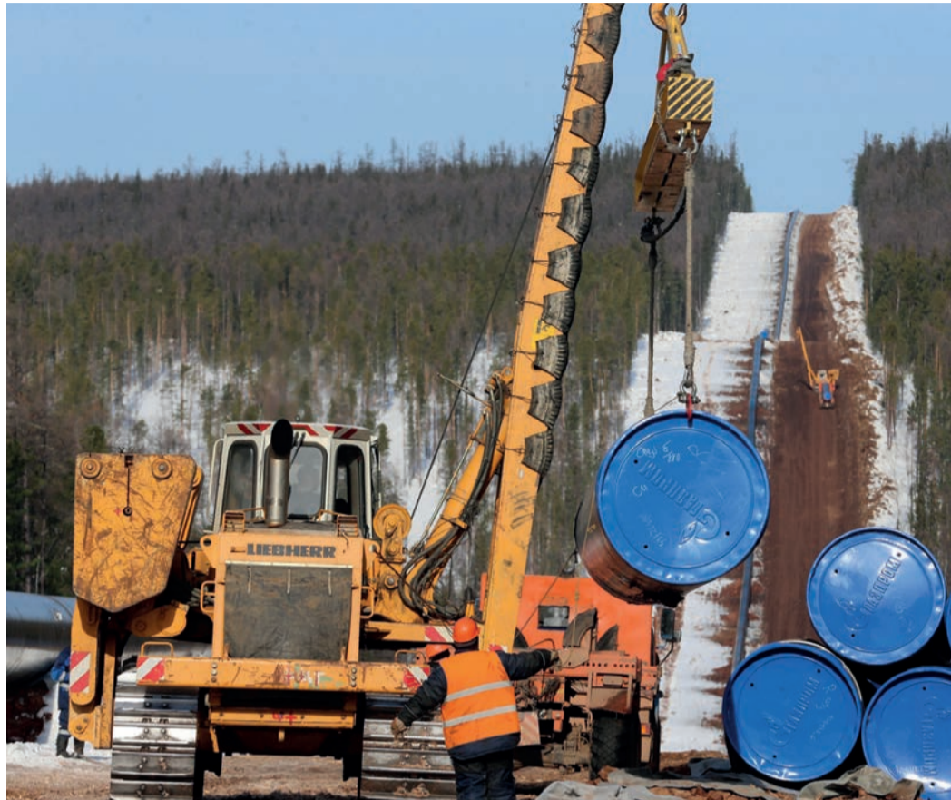
На строительстве МГ «Сила Сибири»
