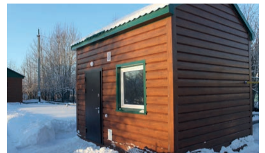
Помещение для газовой котельной
